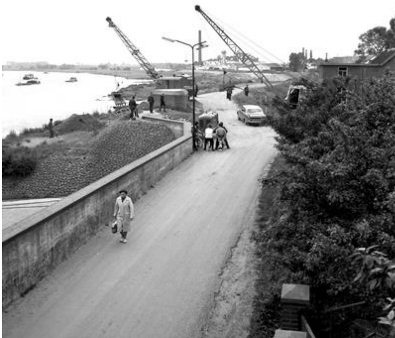
De werkzaamheden beginnen
