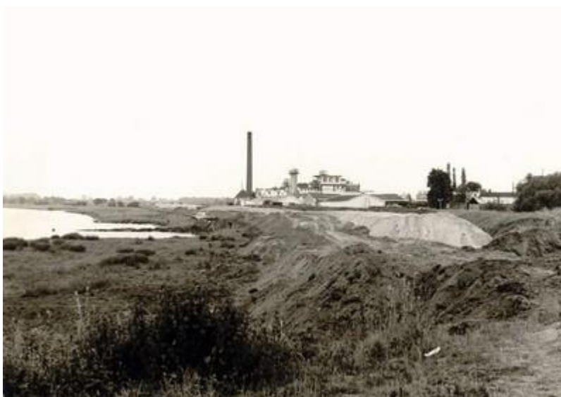
De situatie net voor de aanvang van de werkzaamheden
