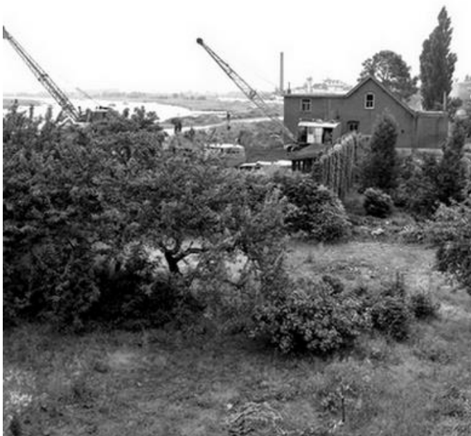
De sloop is begonnen
