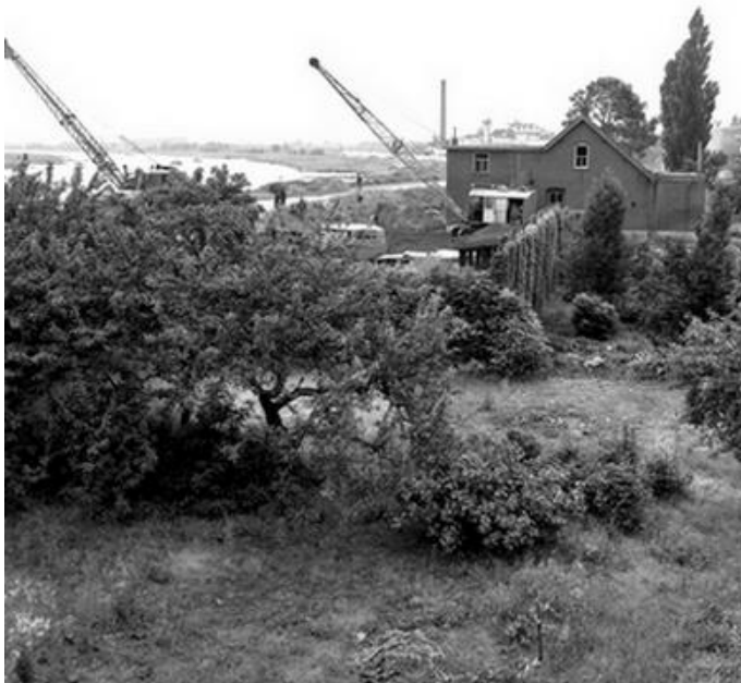
De sloop is begonnen
